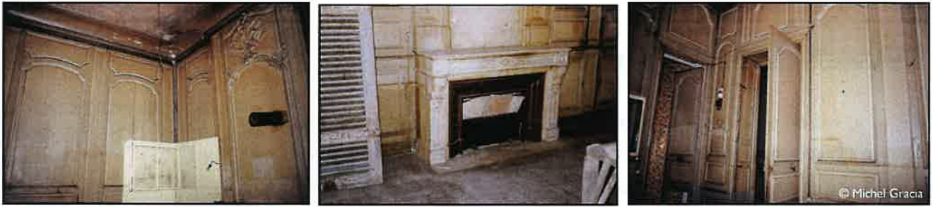
Intérieur d'un appartement avant les travaux
