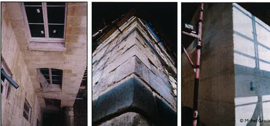
La taille de pierre : cour intérieure après restauration, angle de murs avant et après.
