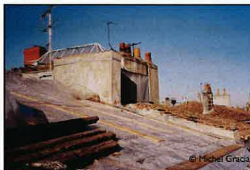
Mise en place des tuiles Monuments Historiques et de gouttières en cuivre
