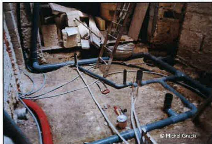
La cour intérieure pendant les travaux
