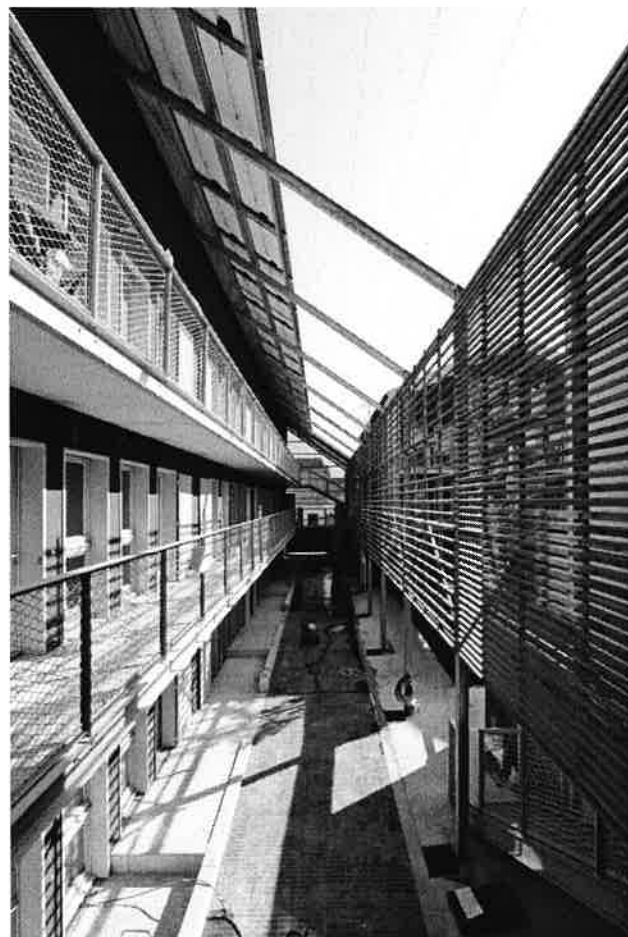
Bâtiment MOOV'ACCESS®, vue sur les coursives extérieures
