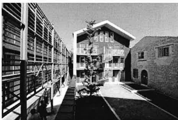
Photo après travaux, Canal, atelier d'architecture
