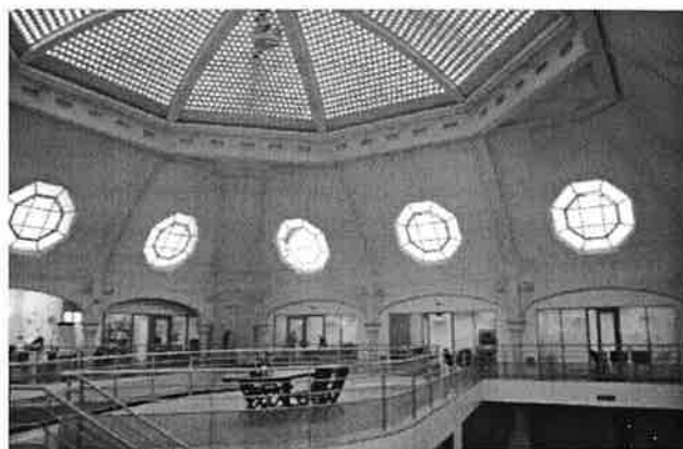
État des lieux avant travaux et vue sur les bureaux à l'étage.
