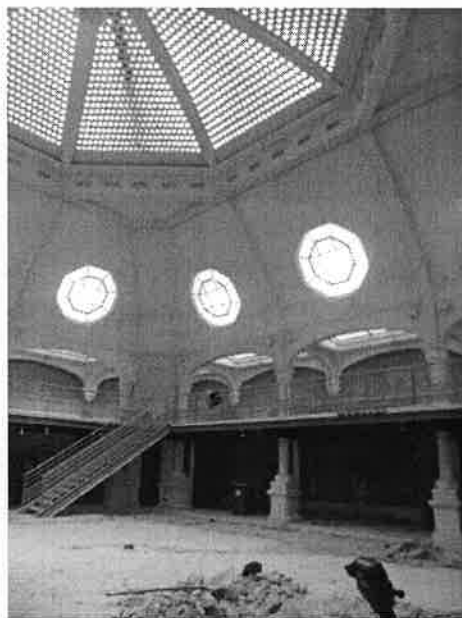
Vue de l'espace au cours de la réfection de la chape au mois de mars 2016.
