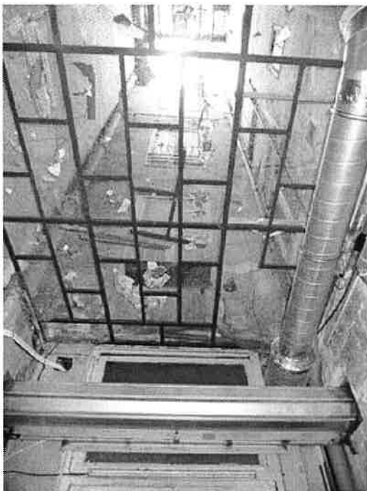
Intérieur avant travaux, crédit agence Marty & Hybre
