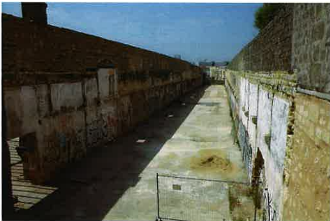
Chai central après démolition
