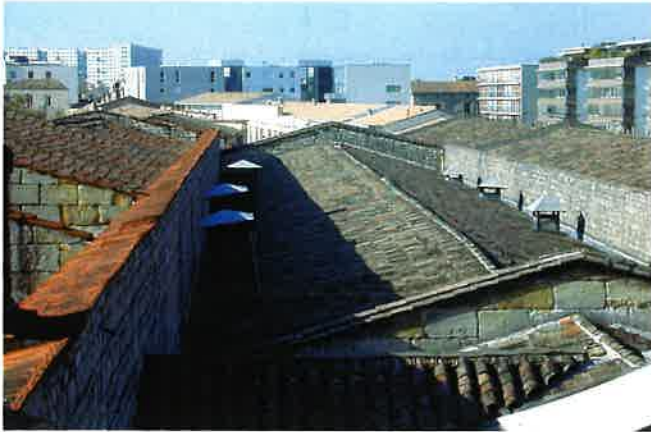
Chai central avant sa démolition
