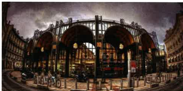
Le marché des Grands-Hommes avant les travaux ©JournalSudOuest
