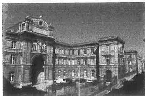
Entrée principale Photo: Serge Daubasse
