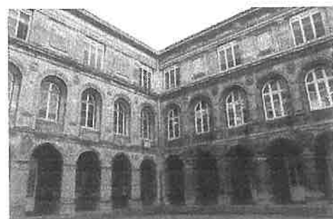
Cour intérieure Photo: Serge Daubasse
