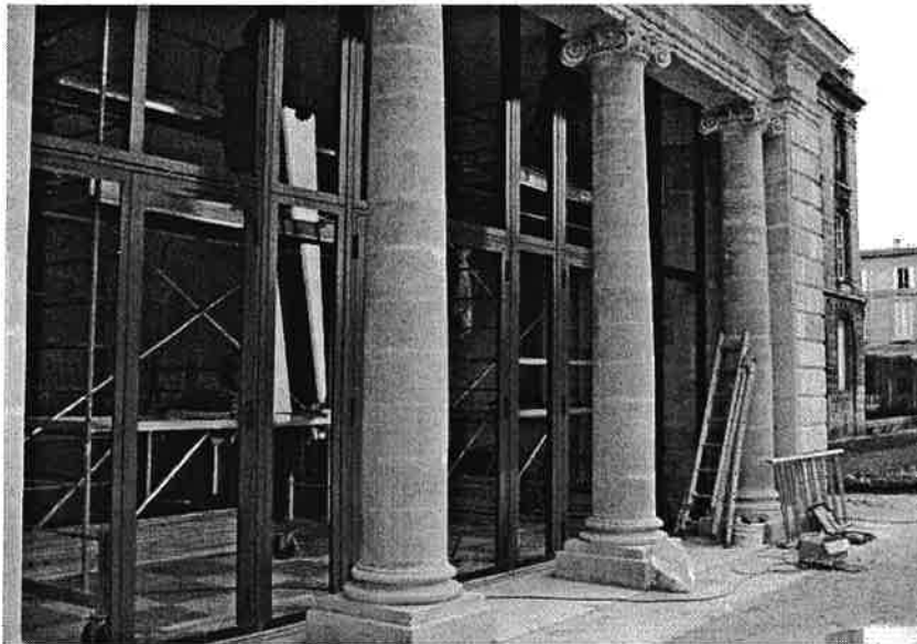
La façade vitrée fermant le bâtiment en cours de réalisation, Photo : Marc Cauty, RCE
