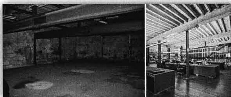
L'avant & après travaux - Le rez-de-chaussée. © bordeauxmetropole.fr
