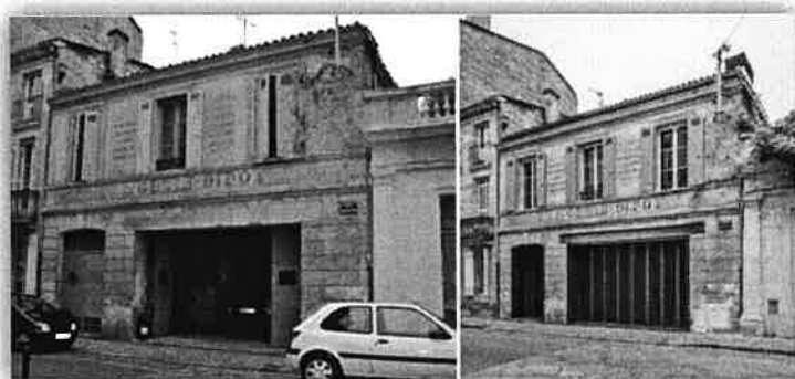
L'avant & après travaux - La façade © bordeauxmetropole.fr
