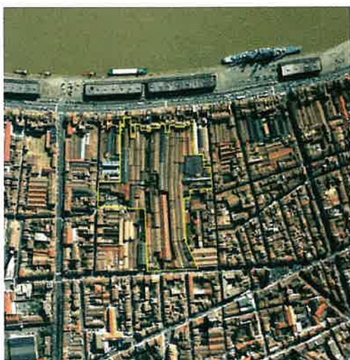
Insertion de l'îlot des Chartrons dans la trame urbaine ancienne. Photo : cabinet BERGUEDIEU BROCHET CHARRIER et RÉOL
