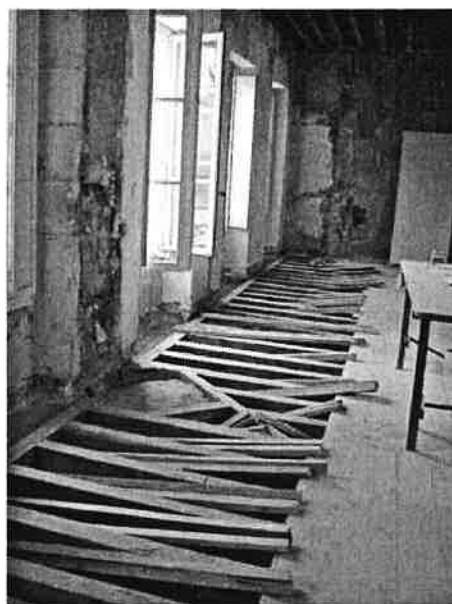
Plancher du second étage faisant apparaître les lambourdes d'époque
