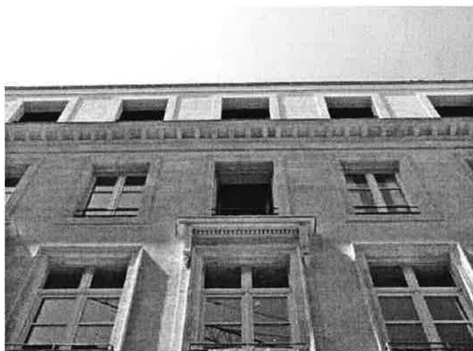
Façade de l'immeuble
