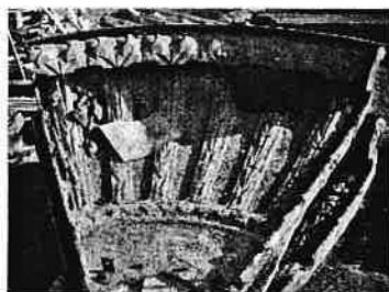
Oxydation de la fonte de la vasque
