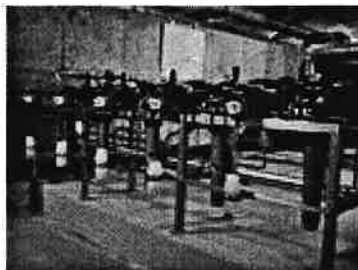
Groupe surpresseurs brouillard
