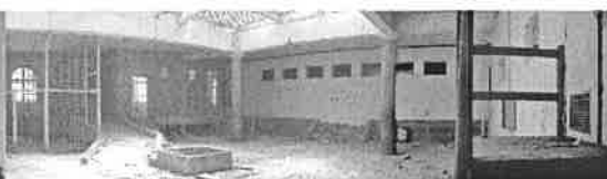
Etat des lieux avant travaux
