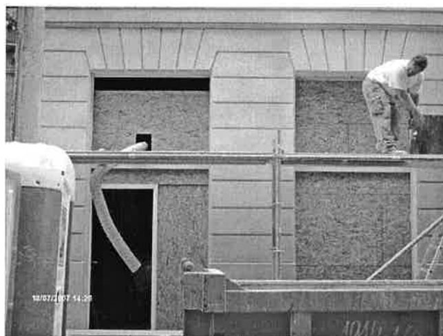
Ravalement, jointement en cours
