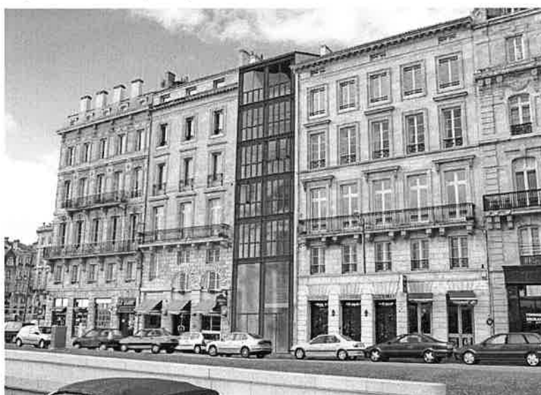
Projet immeuble avec façade métallique
