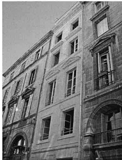
Façade de l'immeuble rue Lafayette, Photo : Manoël Dorget pour RCE
