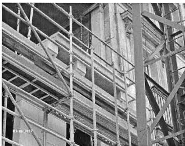
Pose du balcon en cours
