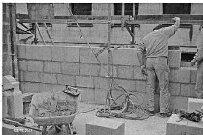
Pose du dernier niveau
