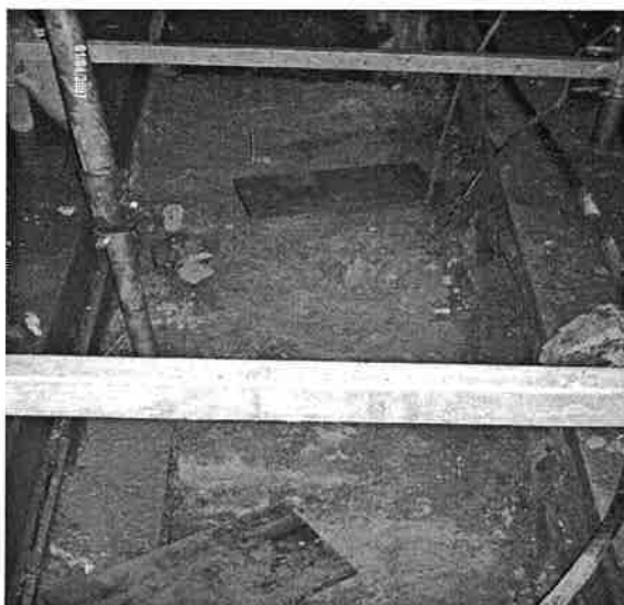
Préparation de la semelle de fondation
