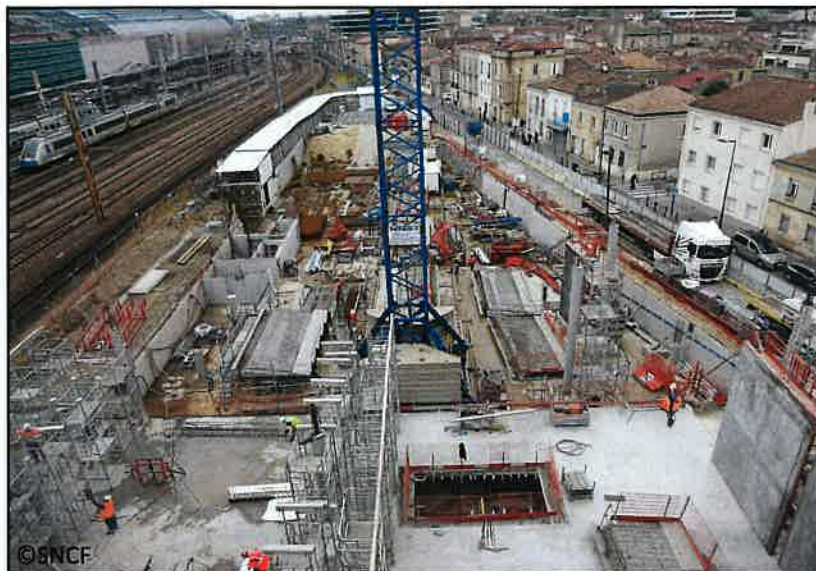
Vue d'ensemble du chantier de l'extension de la gare Bordeaux Saint-Jean, côté Belcier
