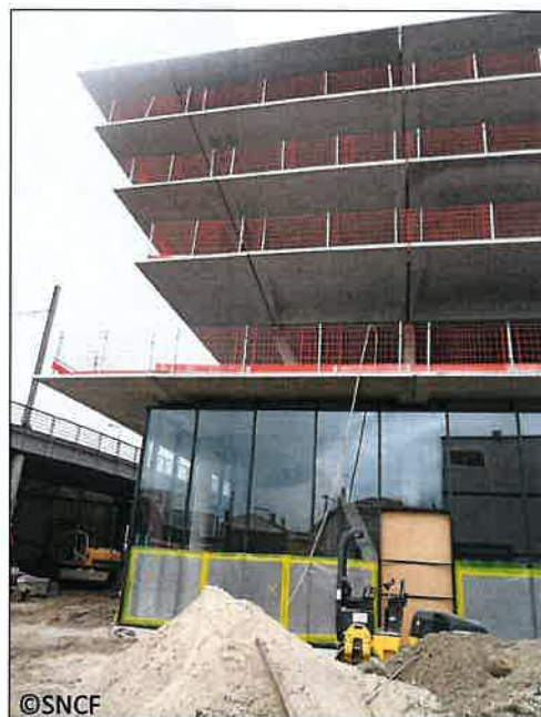
Vue du chantier de construction des parkings (éléments de construction préfabriqués et béton précontraint)
