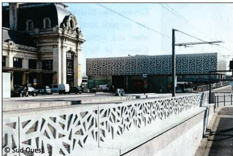
Vue d'ensemble du mobilier urbain contemporain ( dentelle reconstituée en béton fibré)
